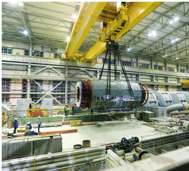
Статор генератора перемещают с помощью полярного крана
