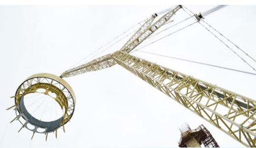
Кран Demag бережно несёт металлическую конструкцию весом 160 тонн
