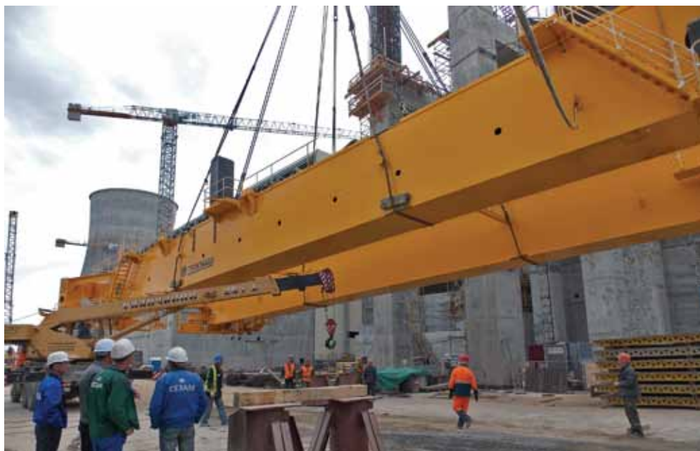
Монтаж полярного крана производства АО «ТЯЖМАШ» на Белорусской АЭС
