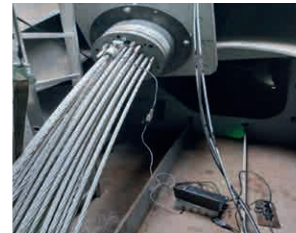
Рис. 3. Анкерный узел с датчиком усилия пряди СТС
