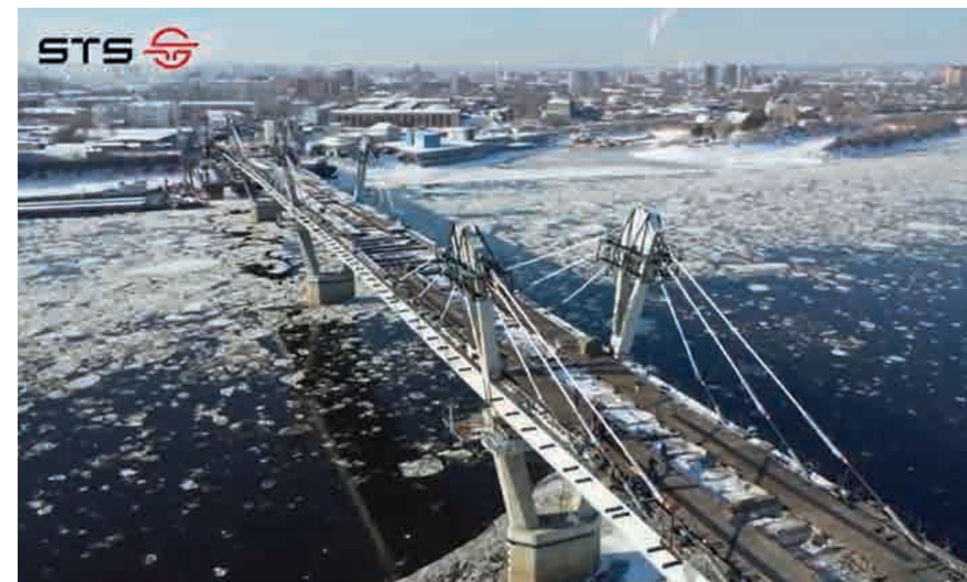
Рис. 4. Строительство моста через р. Зею в г. Благовещенске
