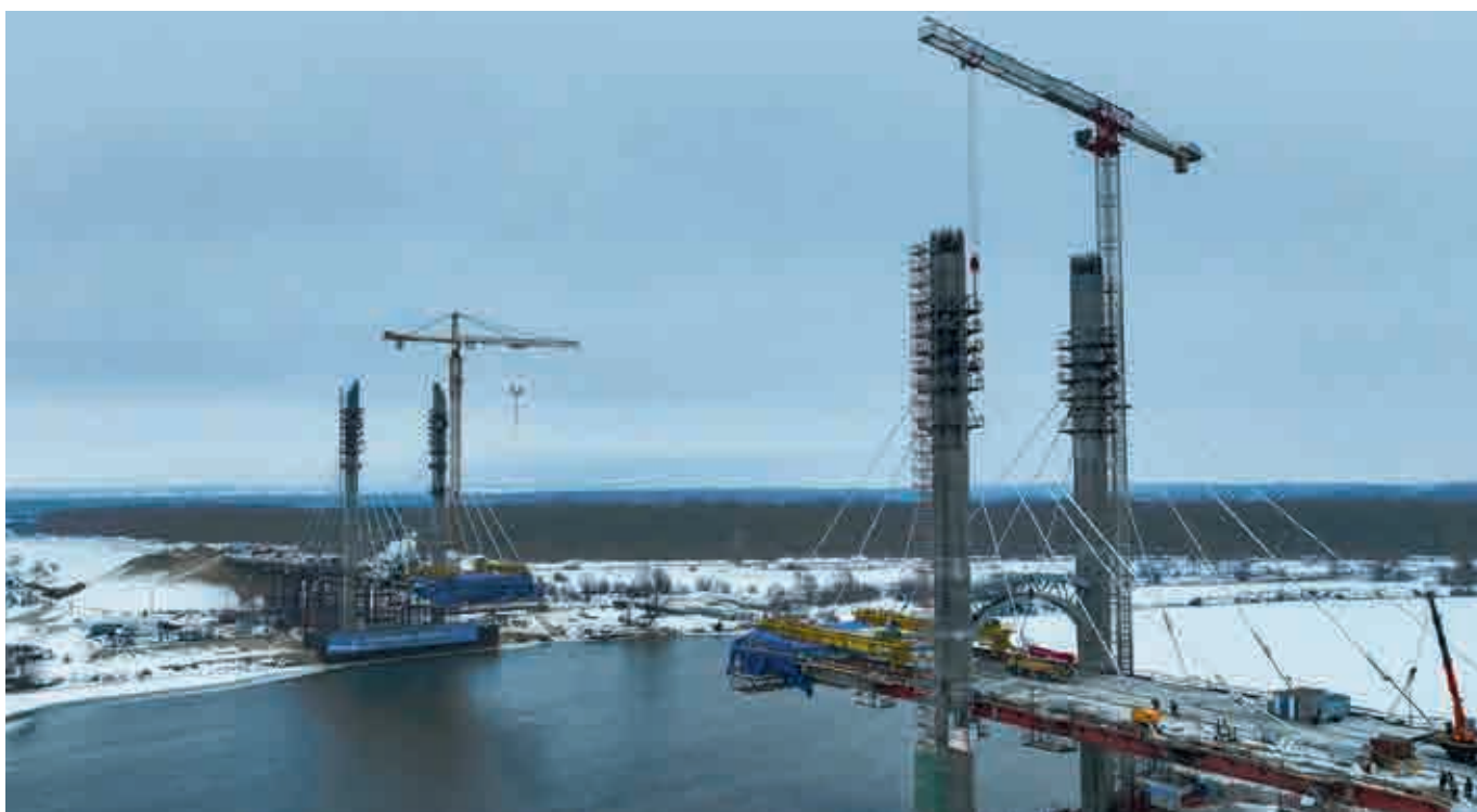
Рис. 1. Строительство моста через р. Оку на автодороге М-12
